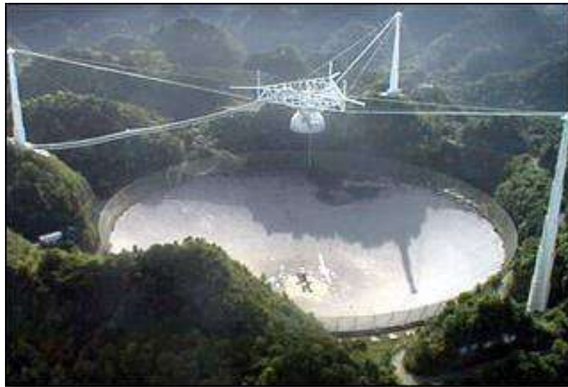
Slika 2: radijski telekop Arecibo, zgrajen v kraterju, 2r = 300\text{m} , projekt SETI, iskanje kvazarjev
