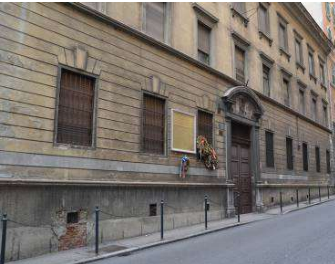
Stavba v Kolonji s spominsko tablo iz leta 2010, kjer je bil novi sedež Posebnega policijskega inšpektorata. (Foto M. I.)
