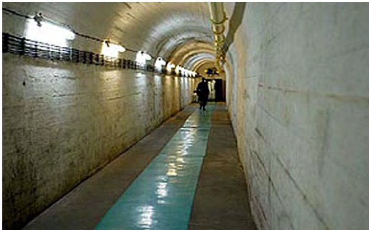
Glavni tunel podzemnega atomskega zaklonišča G-1
